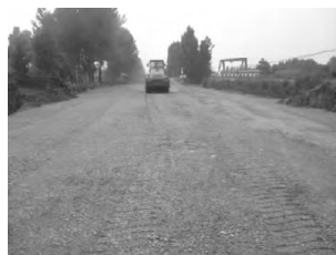
图 5 再生路面材料回填路床
